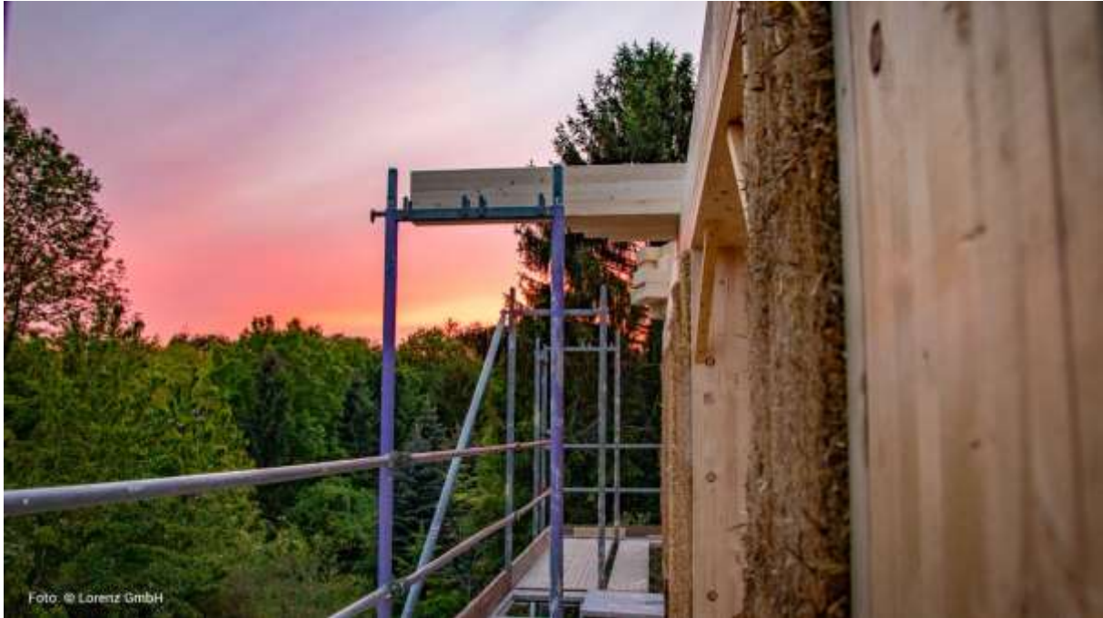
LORENZ DD-Module als Außendämmung an Wand
