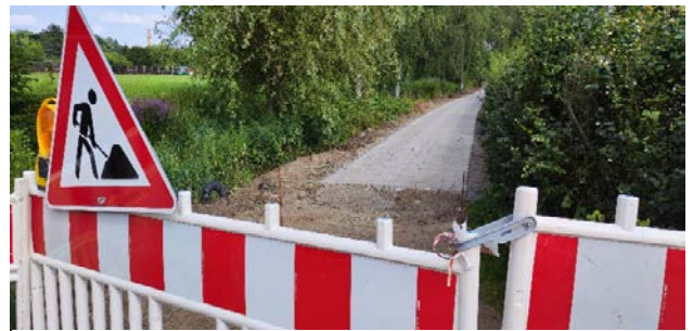
Abbildung 3: Der Weg wird auf zwei Meter Breite gepflastert. Quelle: Klima-Initiative
